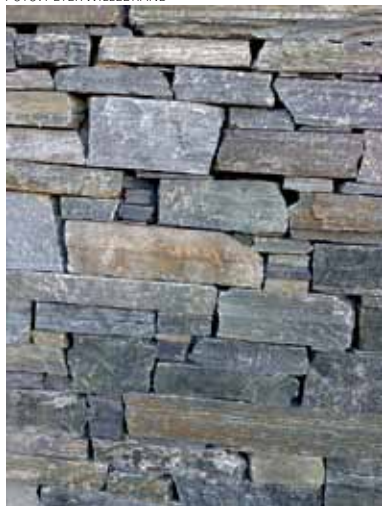
Muren ska så småningom täckas av murgröna där skiffern endast anas i bakgrunden.
