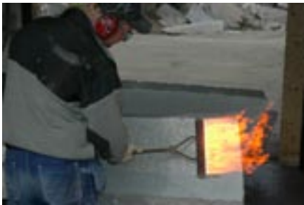
Flamning, manuell kräver effektivt utsug.
