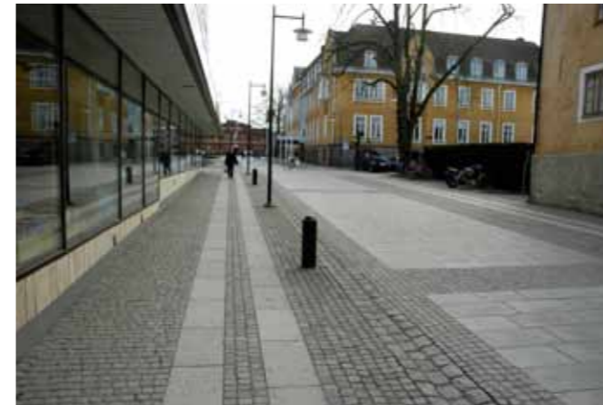
Gatstensbeläggning med gångstråk och fält av granithällar.
