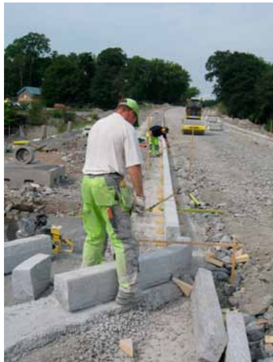
Montering av kantsten, GF1
