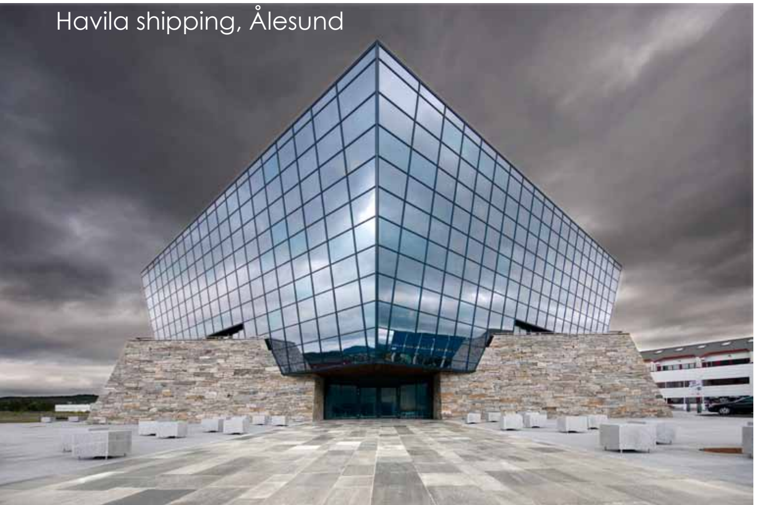
Hovedinngang mot øst med tørrmur fra Norfjoreid som en sokkel, belleggingsstein av Oppdalskifer er lagt på kaiområdet foran inngangen. Foto: Ludvig Killingberg
